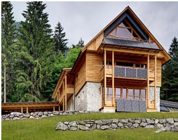
Solarenergienutzung mit denkmalverträglichen CSEM – Modulen und Gestaltungseinbindung in den Baukörper
