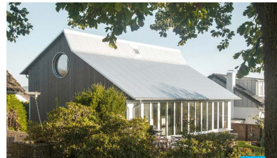
Nutzen, was vorhanden ist: Der in Holzrahmenbauweise erstellte Neubau nutzt den Bestandskeller eines marode vorgefundenen 60er-Jahre-Fertighauses als Sockel. Bauherr: Christian Kiel. Architekten: Büro Marocco GbR Foto: Maximilian Wichary
