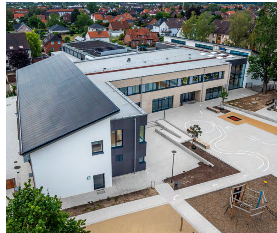
Gebäudeintegrierte Photovoltaikanlage auf den Pultdächern der Grundschule Peine-Stederdorf. Planung: www.passivhaus.de (Foto: Marvin Rust, rustmediasolutions)
