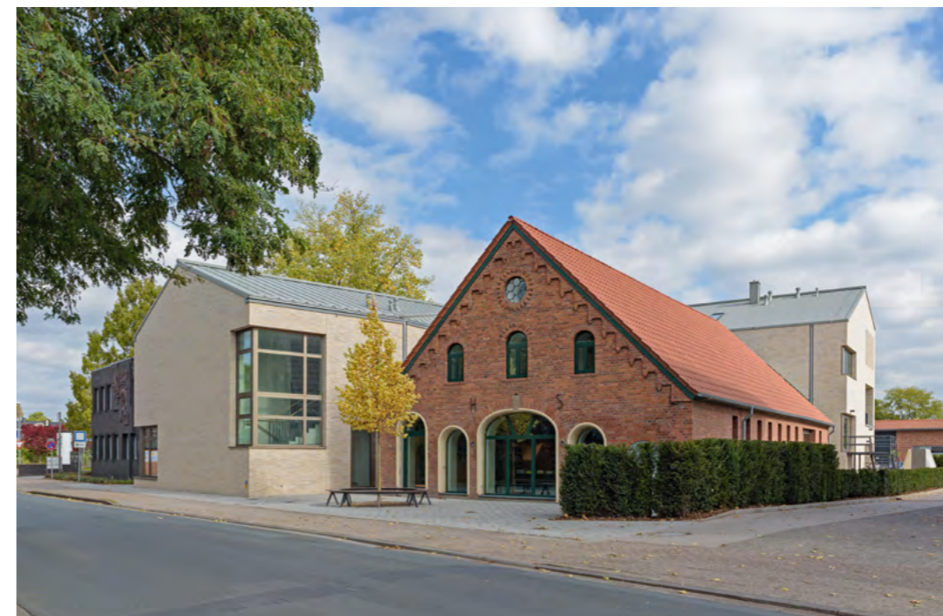
Die Kulturscheune in Leeste beherbergt auf 1.170 m 2 die als „Dritter Ort“ konzipierte Bibliothek. Weitere 470 m 2 stehen der Volkshochschule zur Verfügung. Das alte, ortsbildprägende Bauernhaus wurde von Hübötter Stürken Dimitrova Architekten erhalten und zu einem Ensemble ergänzt. Innenarchitektur und Ausstattung folgen der Idee eines sozialen Ortes für ALLE. „Das geplante Konzept geht total auf, die neue Bibliothek erfährt riesigen Zuspruch und erreicht völlig neue Nutzergruppen. Die Menschen verweilen hier einfach gerne.“ Gemeinde Weyhe – Beide Beispiele wurden nach durchgeführten Wettbewerbsverfahren von den ersten Preisträgern realisiert. (Foto: Jürgen Voss)
